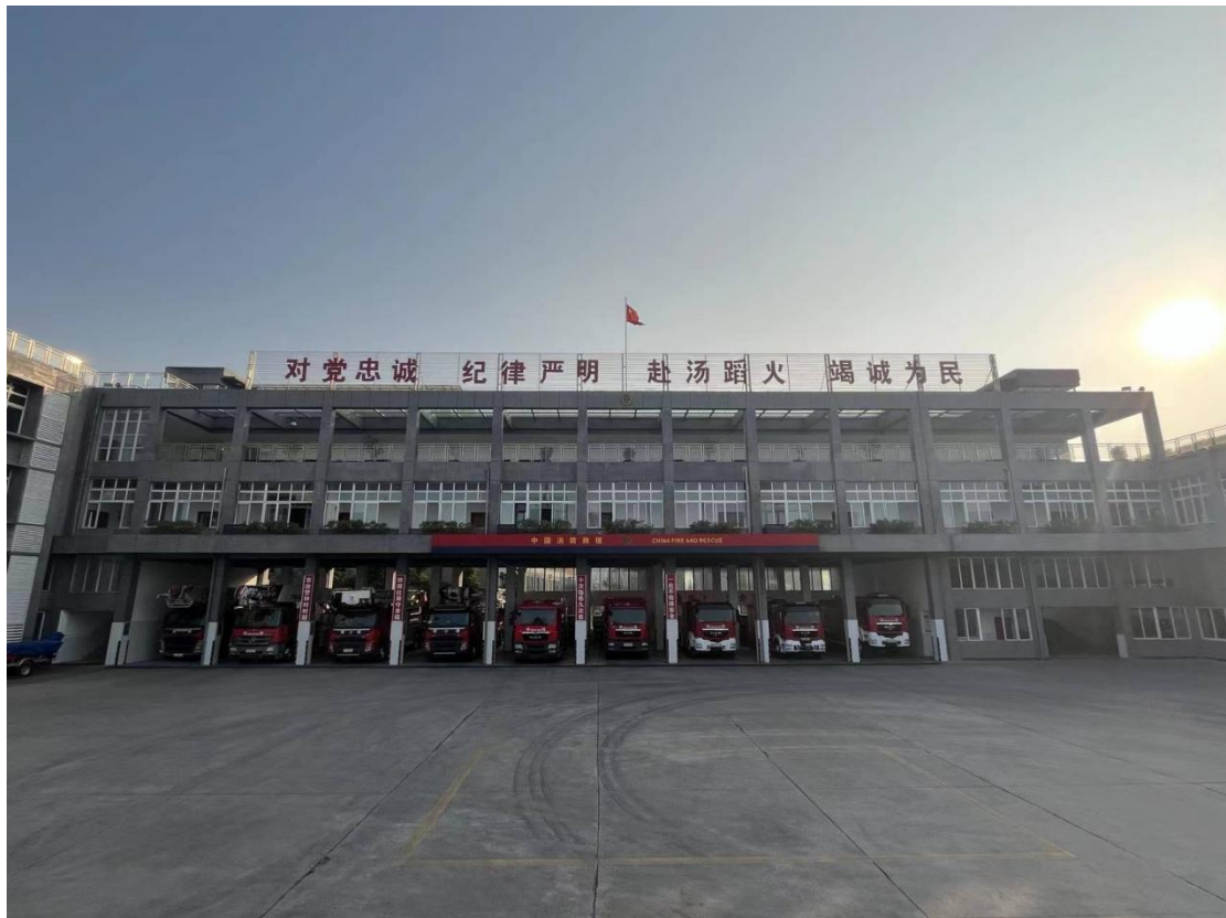
图 3.6 高坪区兴汉路特勤消防救援站
