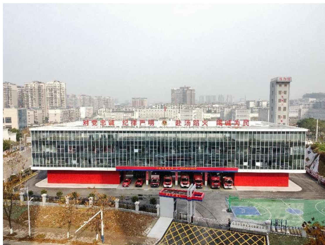
图 3.8 高坪区钻石街消防救援站
