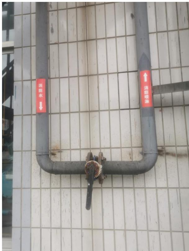
图 2.6-4 室外墙上喷淋开启阀门现场照片
