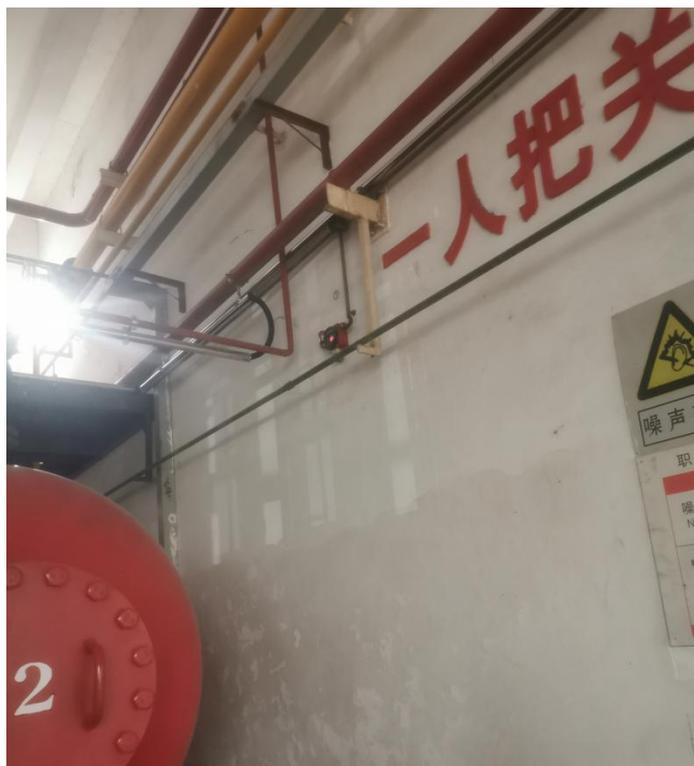
图 2.6-1 氨气探测器现场照片
