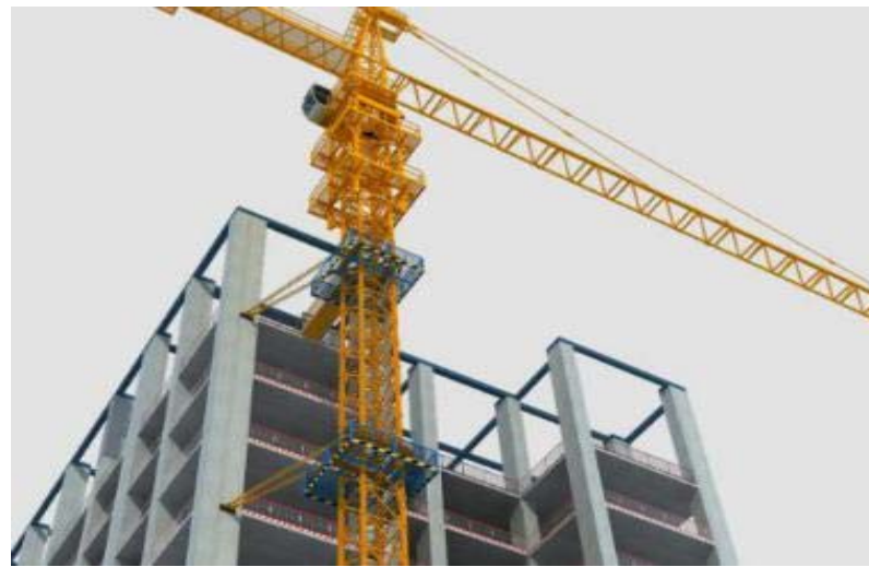
外附着装置安装
