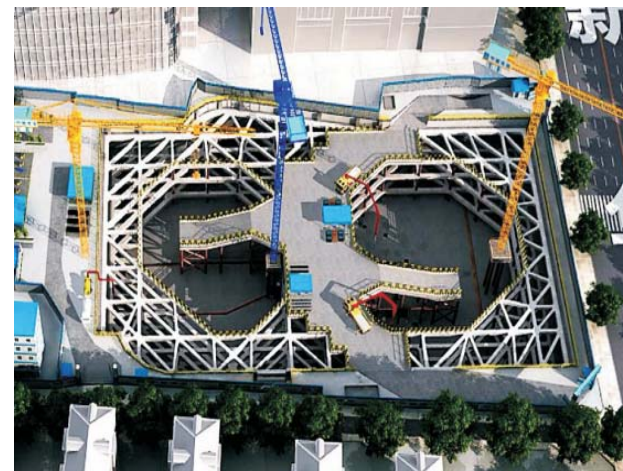
钢筋混凝土支护
