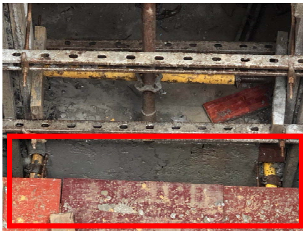
穿钢管，扣件进行固定
