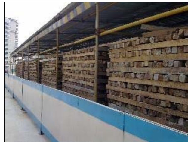
★材料堆放并有防雨措施
