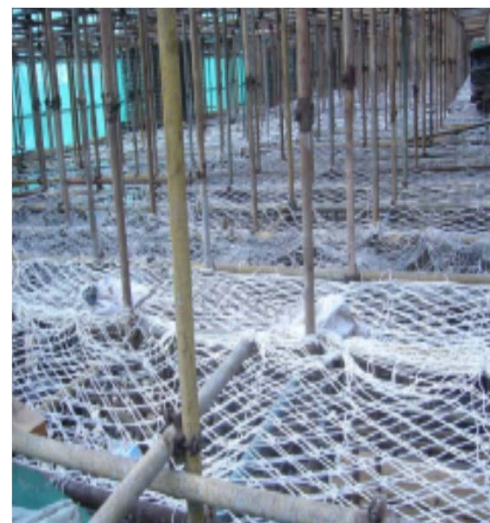
水平防护兜网实例图
