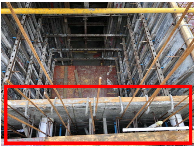
电梯井侧墙预埋PVC套管
