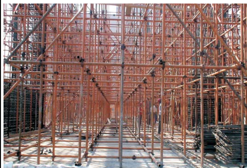
钢管扣件式满堂脚手架
