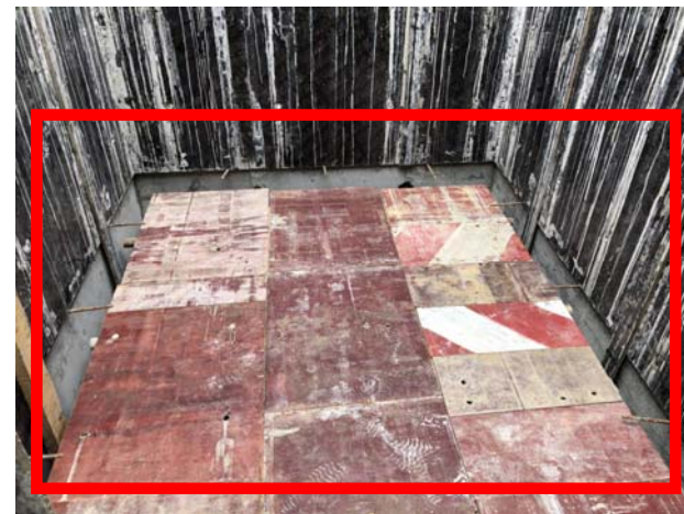
满铺木板（模板）
