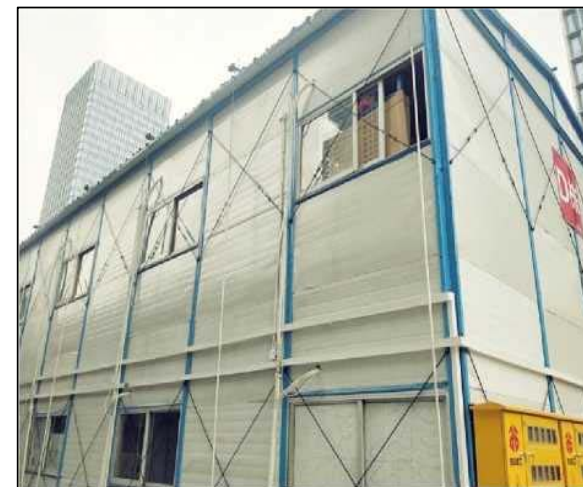
★生活区空调设置专线
