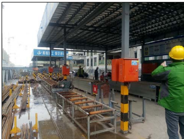
钢筋加工区防护棚
