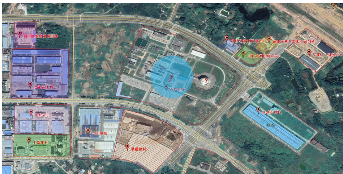
(6) 液化石油气储罐
